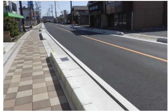
バリアフリー安全対策工事
