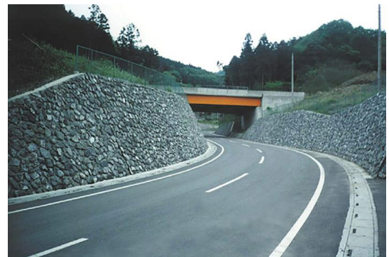
風布 A ランプ工事
