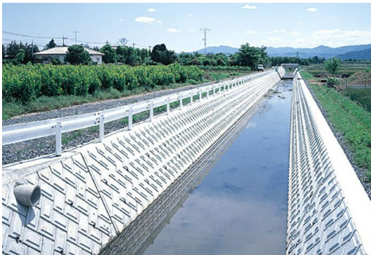
藤治川 護岸工事
